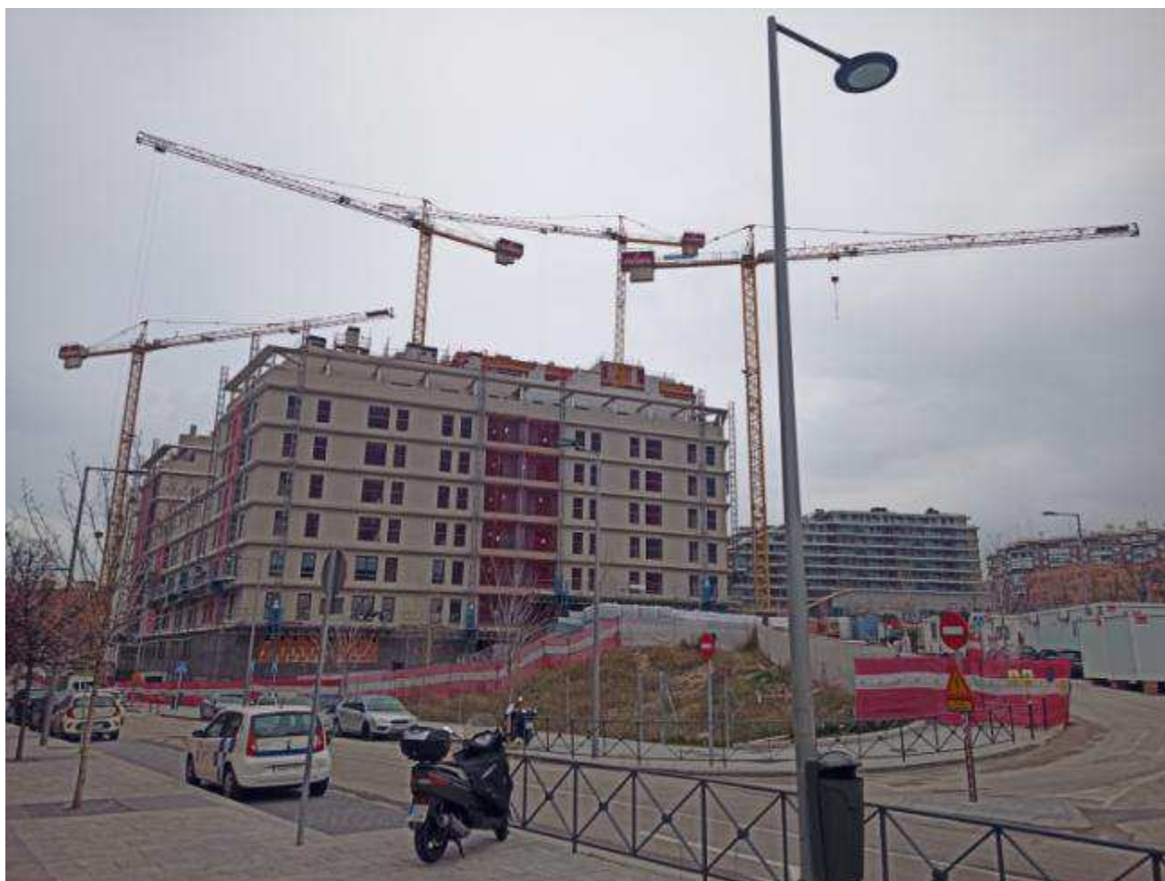
Figura 14. Operación urbanística Mahou-Calderón (Madrid) donde van a construirse 1.300 viviendas. Cercana a ella se encuentra el Pasillo Verde Ferroviario que acabó convirtiéndose en lo que algunos denominaron pasillo del ladrillo ante la ausencia de gran parte de los espacios verdes proyectados.
